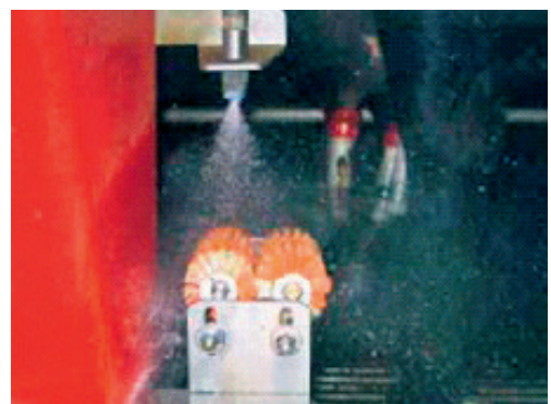
Foto 21: Zwischendesinfektionsanlage mit Peressigsäure.
